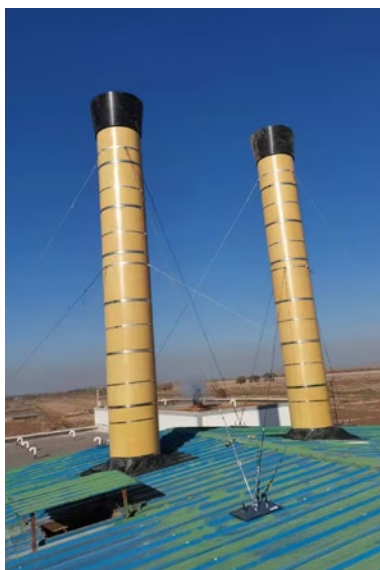
Skorstene fra TPI Polytechnik installeret på en grisefarm i Kina
