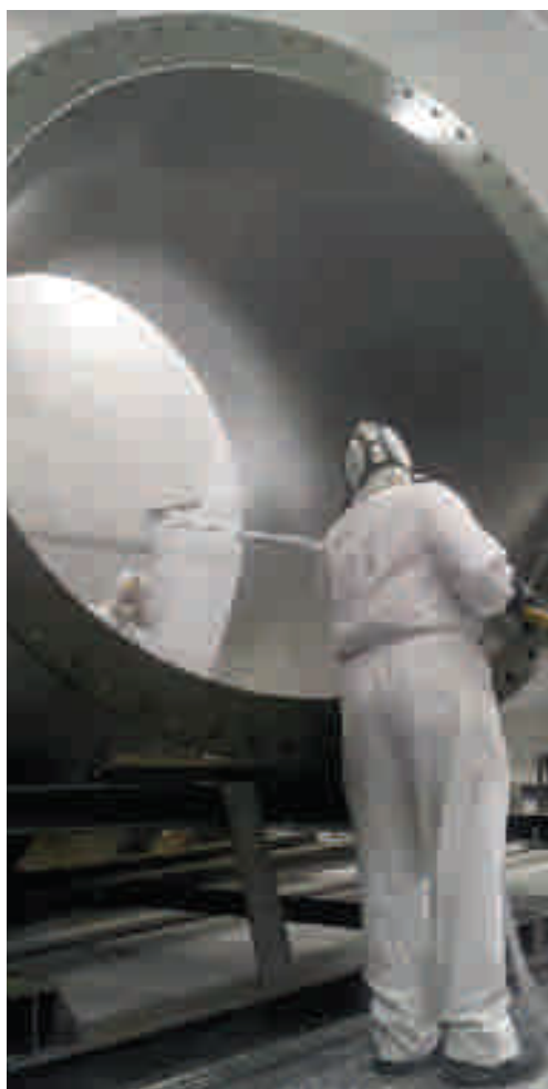
Påføring af korrosionsbeskyttende Accoshield belægning
