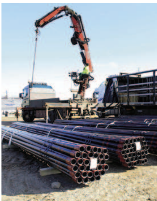
Olierør aflæsses for indvendig coating
